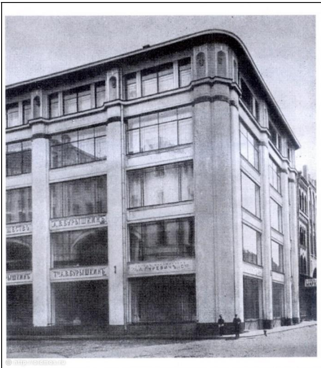
Вид здания со стороны Малого и Большого Черкасского переулков в 1912 году
